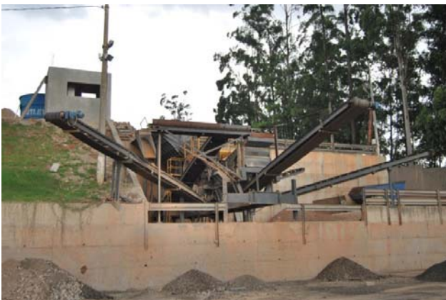
Figura 4. Vista geral do britador de mandíbulas com esteiras transportadoras dos resíduos Fonte: Dados da pesquisa
