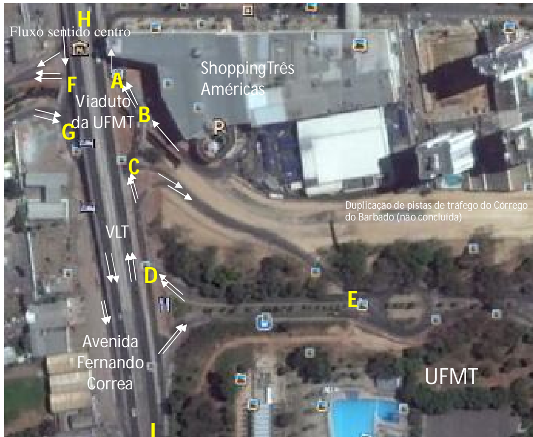
Figura 01 – Caracterização do viaduto da UFMT
