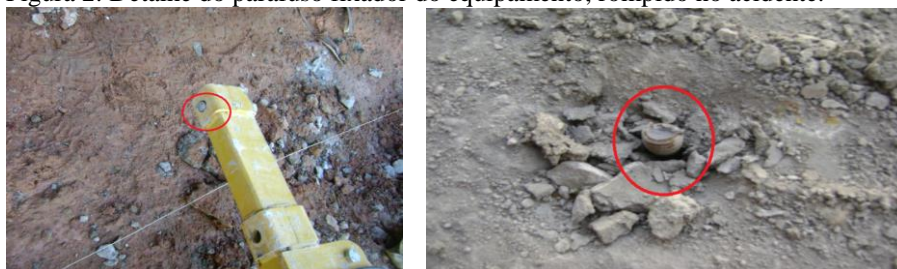
Figura 2: Detalhe do parafuso fixador do equipamento, rompido no acidente.
