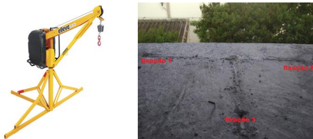
Figura 1: Detalhe do guincho e dos três pontos de fixação na laje.
