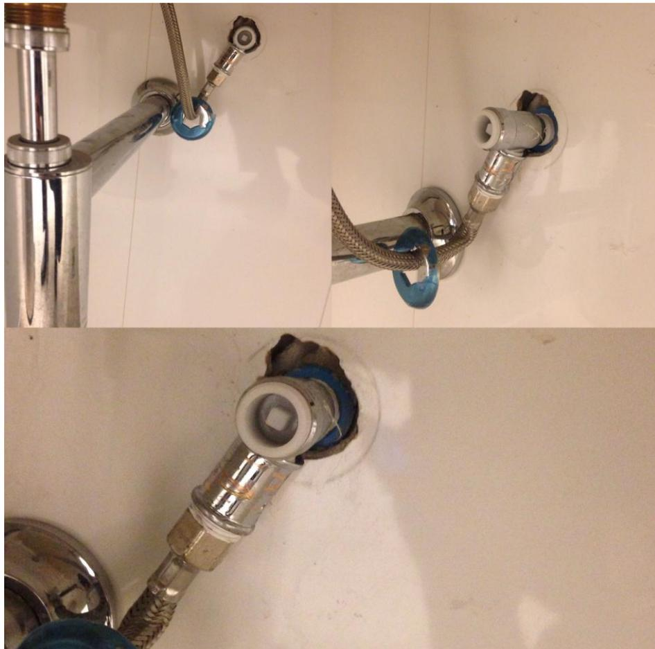
**Figura 3. Foto demonstrando o registro regulador de vazão instalado**
