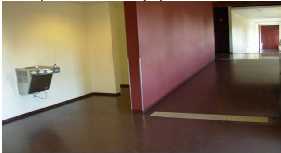
Figura 6 – Bebedouro com altura para pessoas em cadeira de rodas
