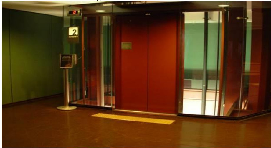
Figura 7 – Acesso ao elevador
