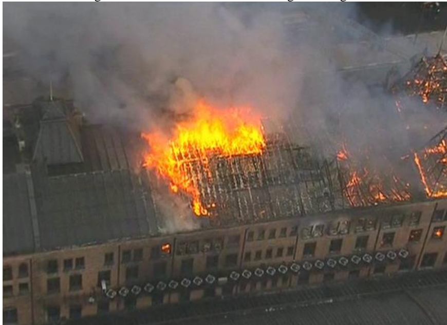
Figura 9 – Incêndio no Museu da Língua Portuguesa
