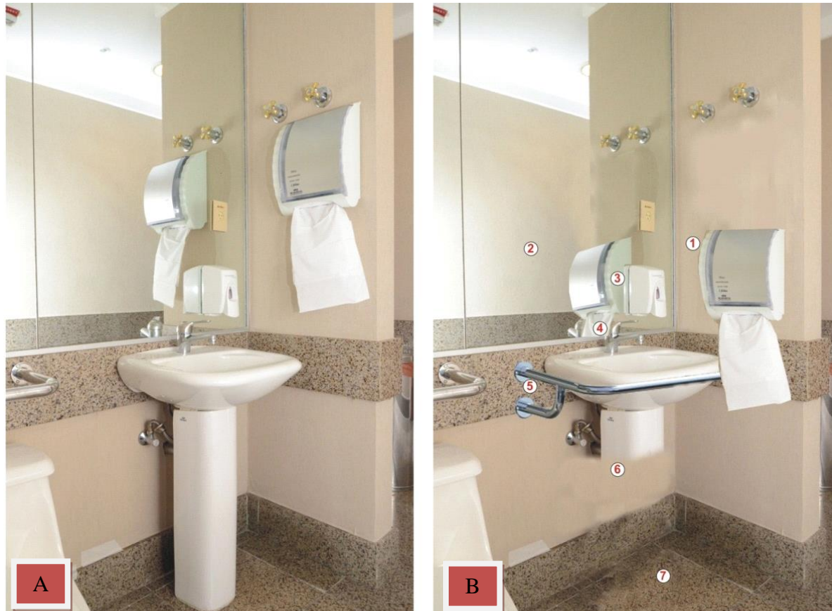
Figura 1 – Comparação existente dos pontos conflitantes em adequação a NBR 9050:2015 Fonte: Monte (2015)
