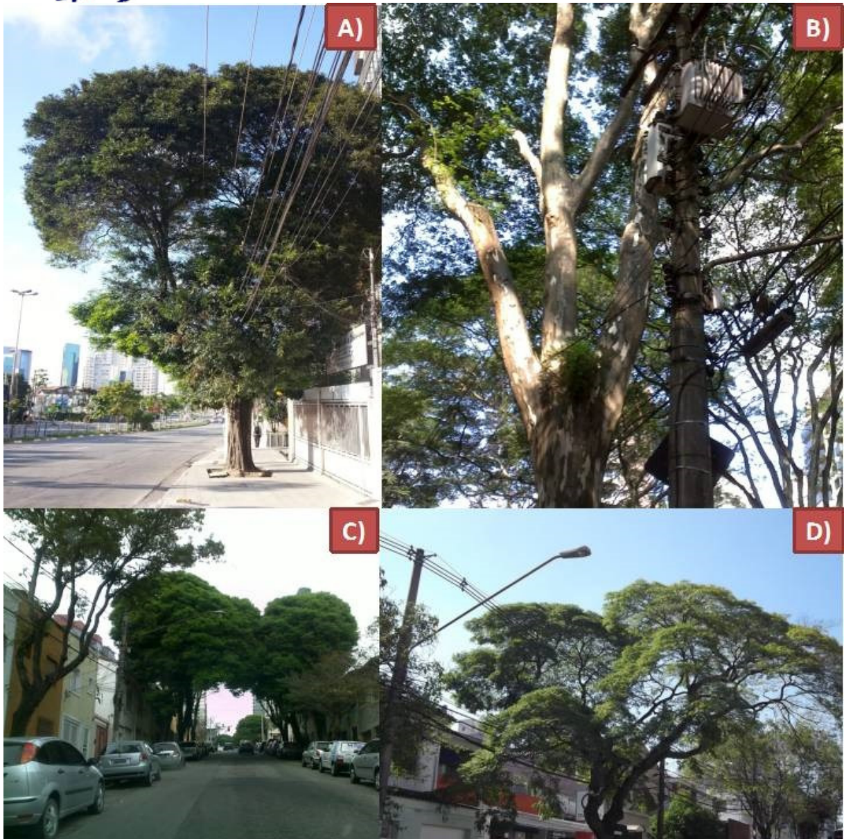
Figura 3. Algumas espécies de árvores de grande porte bem posicionadas convivendo harmonicamente com a rede elétrica.
