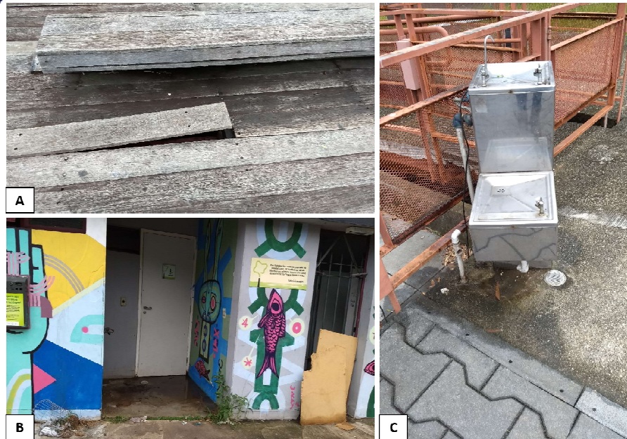
Figura 7. (A) tábua solta, (B) banheiro interditado, (C) bebedouro quebrado Fonte: Autores, 2017.
