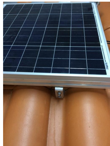
Figura 1 –Suportes utilizados para fixação das placas fotovoltaicas: (A) suporte antigo; (B) suporte desenvolvido pela empresa Ômega; (C) suporte novo antes da instalação da placa fotovoltaica e (D) suporte novo com a placa fotovoltaica instalada.
