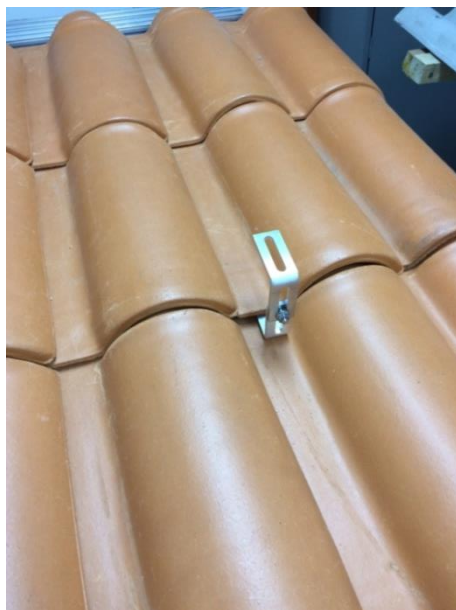
Figura 1 –Suportes utilizados para fixação das placas fotovoltaicas: (A) suporte antigo; (B) suporte desenvolvido pela empresa Ômega; (C) suporte novo antes da instalação da placa fotovoltaica e (D) suporte novo com a placa fotovoltaica instalada.
