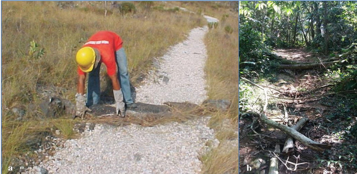
Figura 3a. Exemplo de drenagem por barreira de escoamento em pedra do Parque Nacional da Chapada dos Veadeiros, apresentado por Andrade e Rocha (2008); Figura 3b Situação encontrada em trilhas da região de Parelheiros em que os esportistas utilizam da queda natural das árvores como obstáculos a serem superados.
