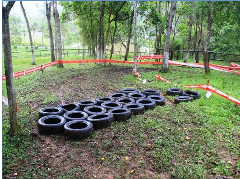
Figura 4. Modelo de uso de pneus para áreas úmidas e ou encharcadas com o intuito de criar obstáculos e que também terá a função dupla de diminuir ou mitigar os impactos decorrentes do transito de motocicletas off road em trilhas.
