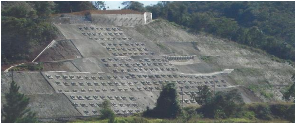
Figura 01: Muro de contenção em solo grampeado.
