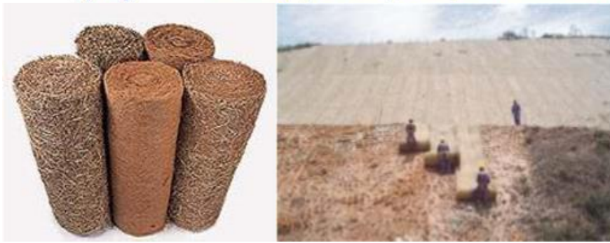
Figura 4. Rolos de biomantas e aplicação ao solo
