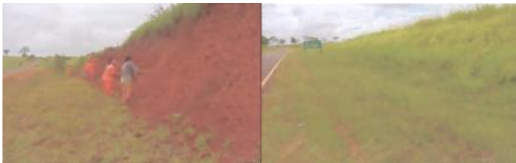
Figura 8. Preparação do solo para a hidrossemeadura e talude finalizado
