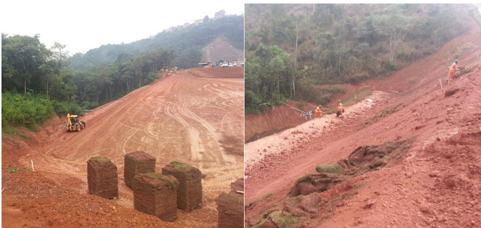
Figura 7. Gramas em placa e aplicação das placas (Rodoanel Norte – Lote 04/SP)
