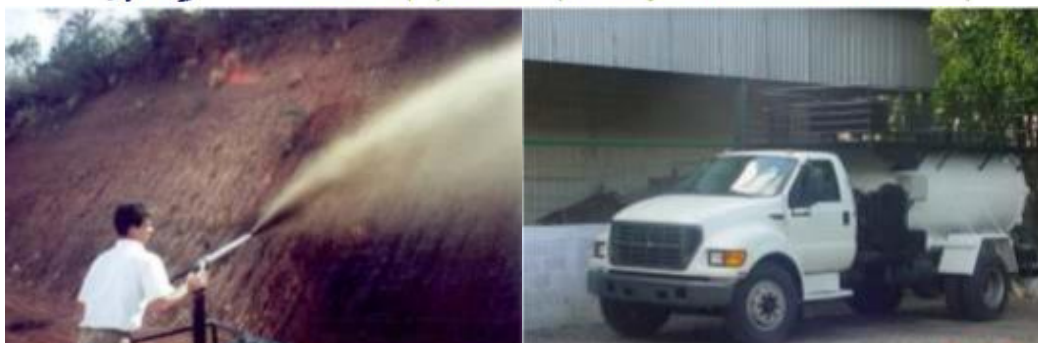
Figura 5. Aplicação da hidrossemeadura e caminhão adaptado
