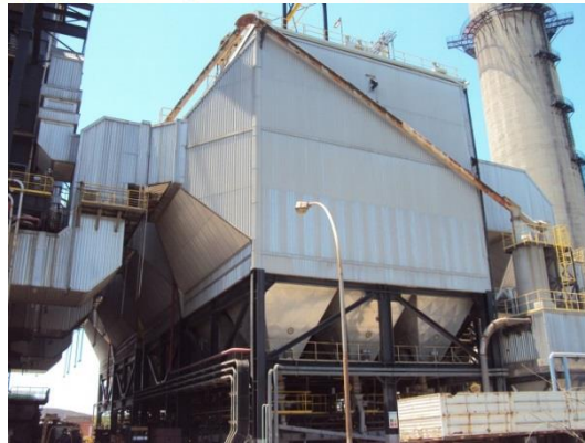
Figura 2 Precipitador eletrostático.
