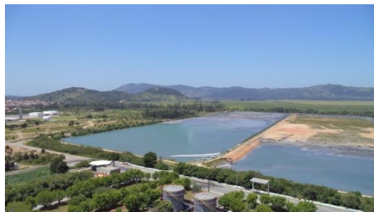
Figura 1 Bacias de decantação de cinzas pesadas.
